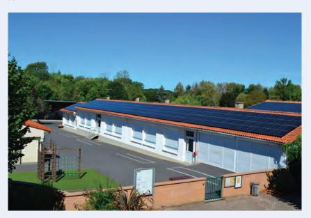
580 mètres carrés de panneaux photovoltaïques sont installés sur les toits de l'école primaire et de la salle polyvalente. L'électricité qui sera fournie par ces panneaux sera réinjectée dans le réseau électrique, ce qui permettra de diminuer très sensiblement les factures d'énergie du groupe scolaire, de la mairie, de la salle polyvalente et des salles annexes.
